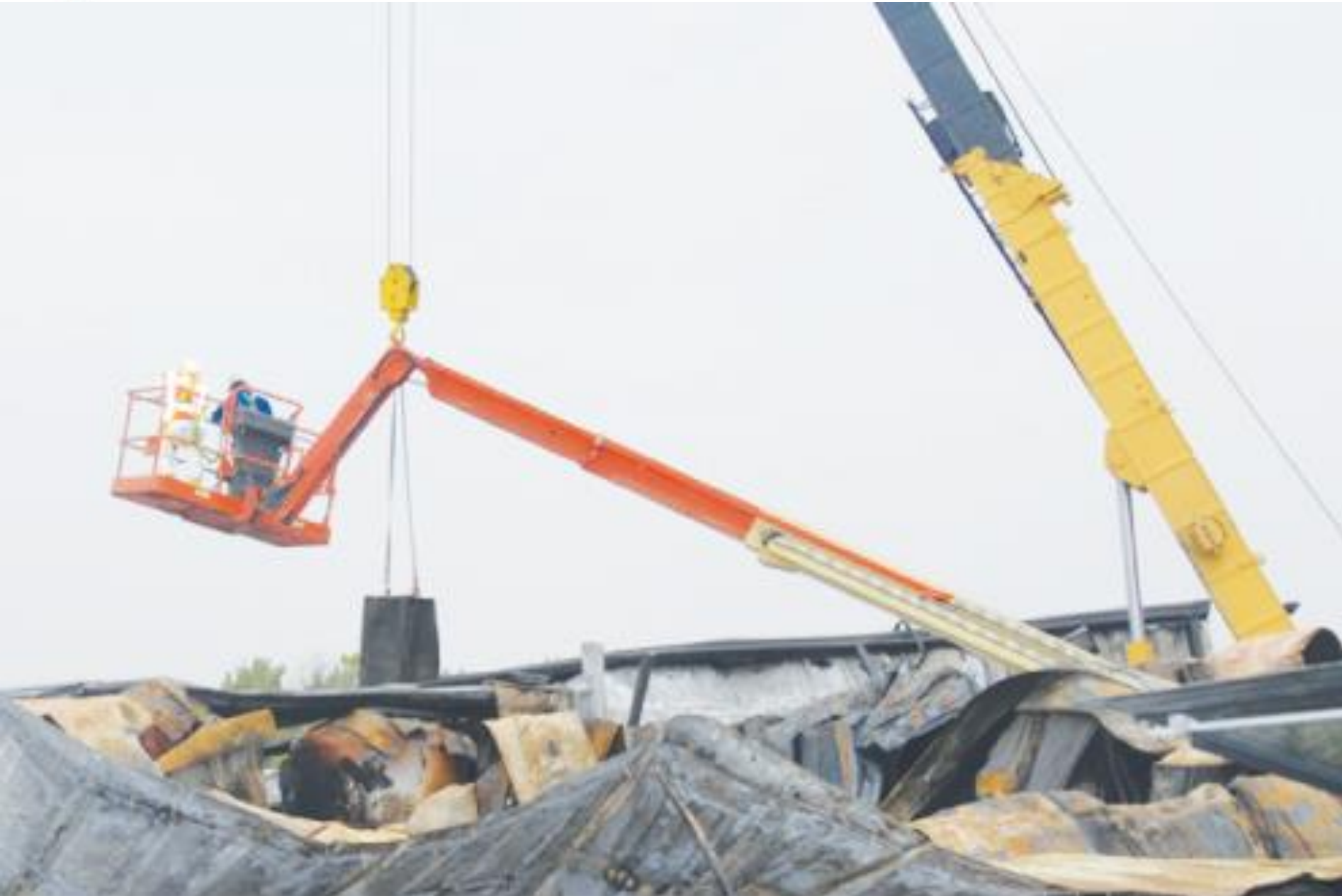
Figura 13.2.3.5 Uso de una pluma articulada para inspeccionar la escena del incendio antes de ingresar a la escena del incendio. El personal usa equipo de protección contra caídas y el operador está debidamente capacitado.
