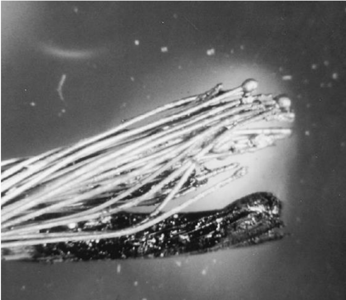
FIGURE 9.10.2.2 Cable de cobre trenzado de una bombilla afectado por un cortocircuito.
